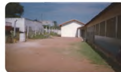
Construção dos sanitários concluída.
