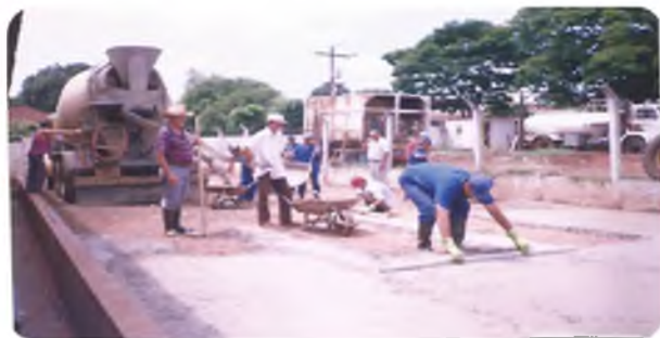
Pátio da Escola sendo concretado /1998.
