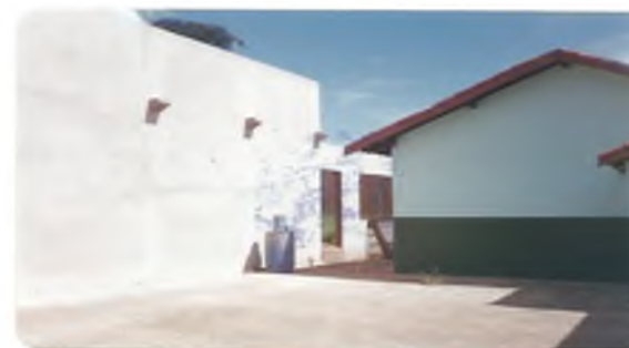
Construção de mais uma sala de aula /1999.
