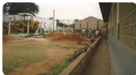
Construção dos sanitários dos alunos.
